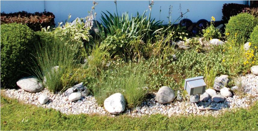
1. Bedenken Sie immer – unter der Begrünung befindet sich ein Dach, die Abdichtung darf nicht beschädigt werden, denn sonst leidet das darunter liegende Bauwerk. Die Abdichtung sollte so ausgeführt sein, dass sie für eine Begrünung geeignet ist.
